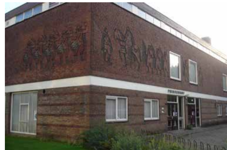
* Gebouw Prinsenhof, voormalig onderkomen van het Bureau PGU, wordt gesloopt. Op deze plek komt een gezondheidscentrum.
